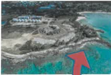
Immeuble en ruine sur la parcelle AL 551
